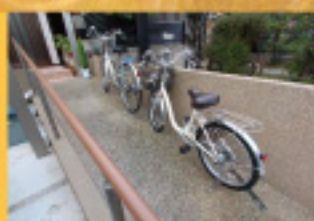
車椅子になっても大丈夫な立 降スロープ。自転車置き場は倒 れにくいように、後輪を埋め込む 当社の自備作。
