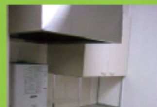
特殊な形状で、何度も現場測 量と打合せを重ね、板金屋さん にオーダーメイドしたフード。今 では工事の思い出です。
